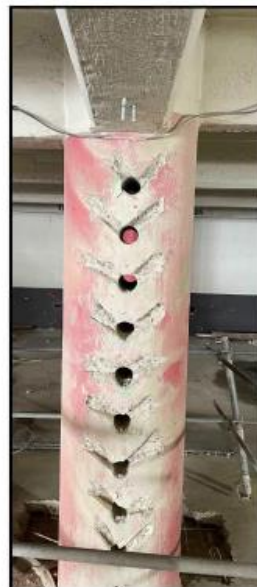
POSE D'ÉTRIERS POUR MISE EN PLACE RAPIDE DE LA POUTRE PRS DE REPRISE.
