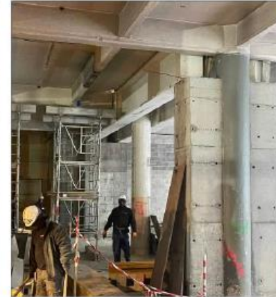
REPRISES EN SOUS-OEUVRE POTEaux AMPHITHÉÂTRE
