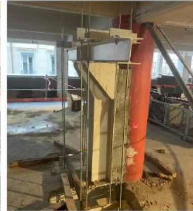
REPRISES EN SOUS-OEUVRE POTEaux AMPHITHÉÂTRE
