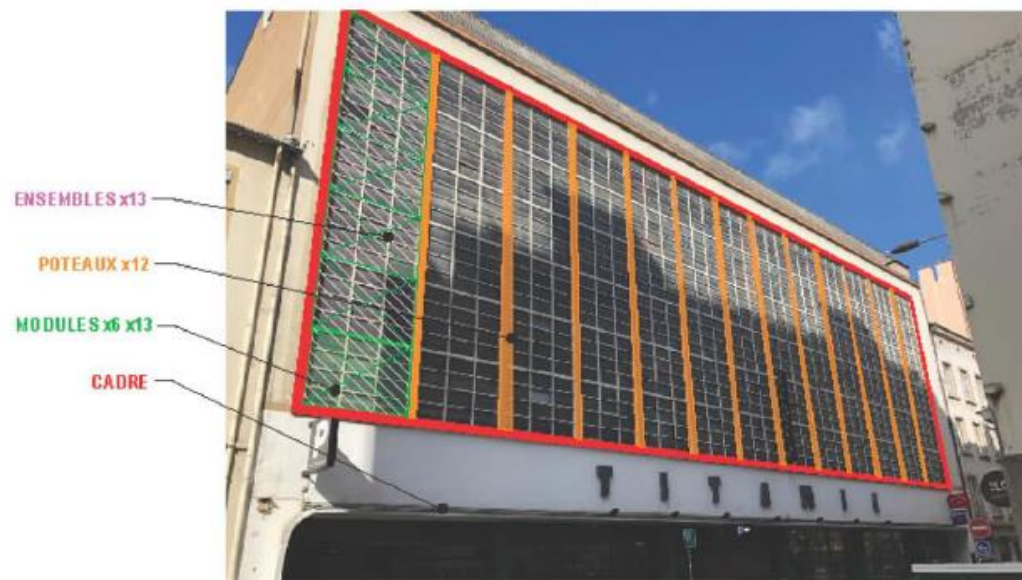
FAÇADE PRINCIPALE | EXISTANT
