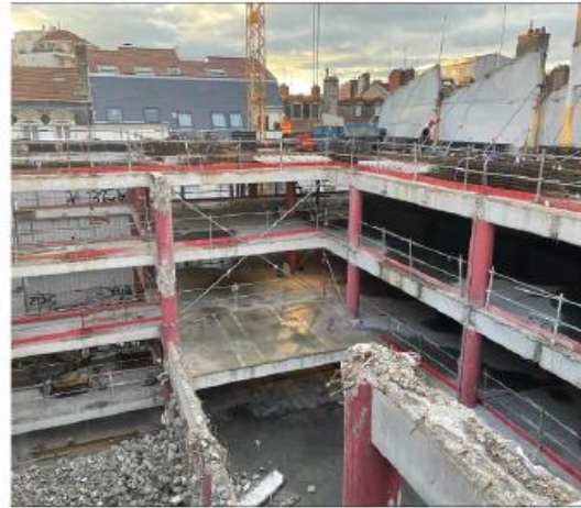
REPRISES EN SOUS-OEUVRE POTEaux AMPHITHÉÂTRE
