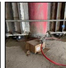
SUPPRESSION DES POTEAUX DU RDC
