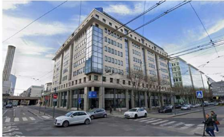
Vue 1 - Angle Sud Est
