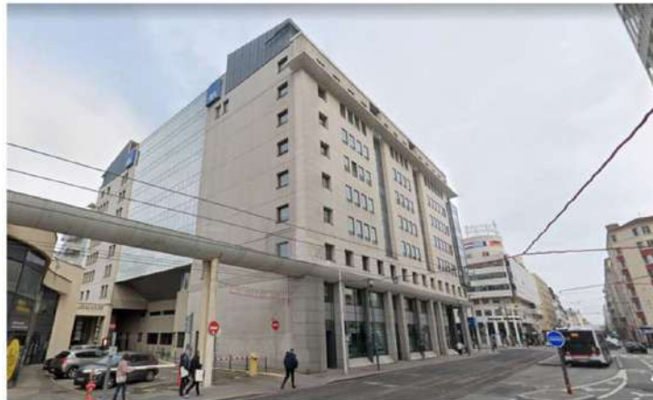
Vue 3 - Angle Sud Ouest
