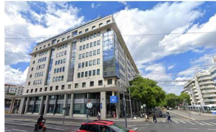
Vue 4 - Angle Sud Est
